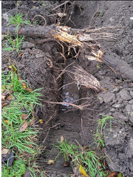
Op de bodem van de sleuf schittert het grondwater.
